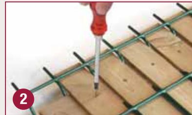
2 Vissez ou agrafez les lattes au niveau des plis. Il faut mettre un point de fixation au niveau de tous les plis.
