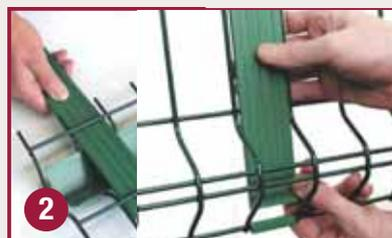
Insérez les lattes verticales de 45 mm en les bloquant en partie basse sur les clips. Ne pas mettre les lattes des mailles se situant aux extrémités du panneau.
