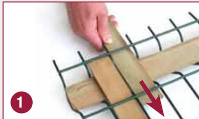
1 Posez les lattes horizontales dans les plis. Insérez les lattes verticales sauf celles des mailles d'extrémité.
